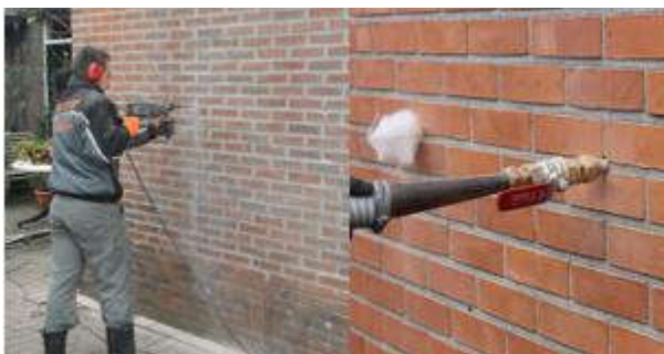
Isolatie in de gevel
