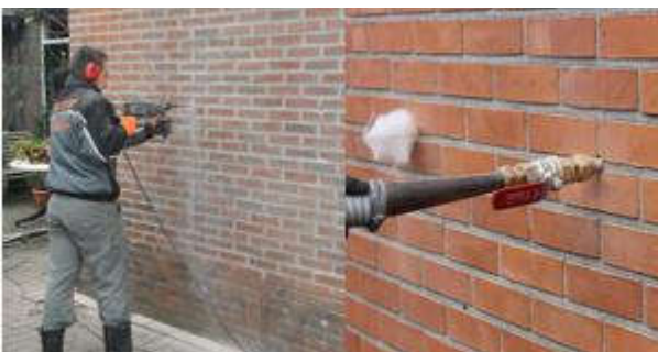
Isolatie in de gevel
